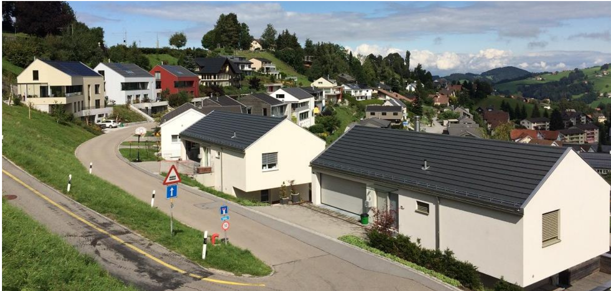
Abbildung 3: Die Bebauung sensibler Hanglagen wirkt geordneter und eingepasster, wenn einfache Regeln geschaffen werden. An diesem Hang sind die Giebel mehrheitlich den Höhenlinien entlang ausgerichtet. Das schafft ein ruhiges Gesamtbild.
